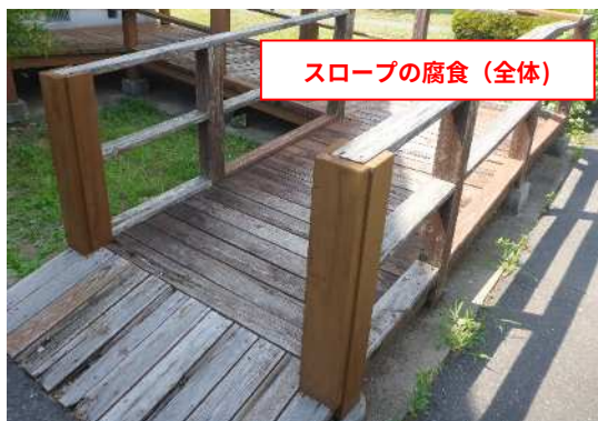
写 5 スロープ：腐食【D判定】
