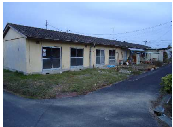
簡易耐火造の山の神住宅
