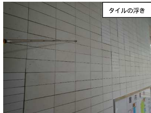
写 4 壁面：タイルの浮き【C判定】
