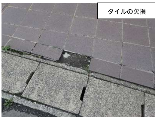
写 5 外構：タイルの欠損【B判定】
