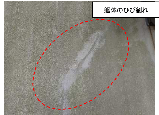
写 2 外壁：躯体のひび割れ【C判定】
