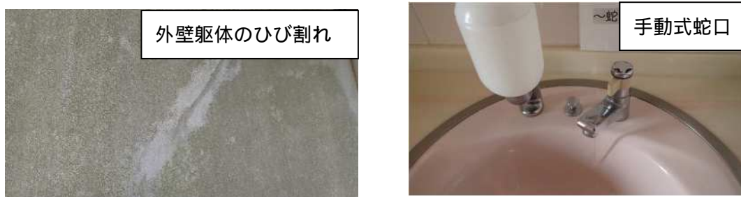
図4 劣化した部材の例
