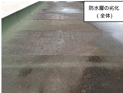
写 1 屋根：防水層の劣化【C判定】
