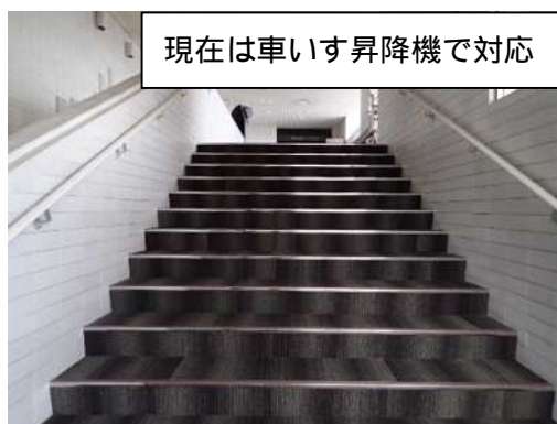
図5 段差解消に対する改善が必要な例
