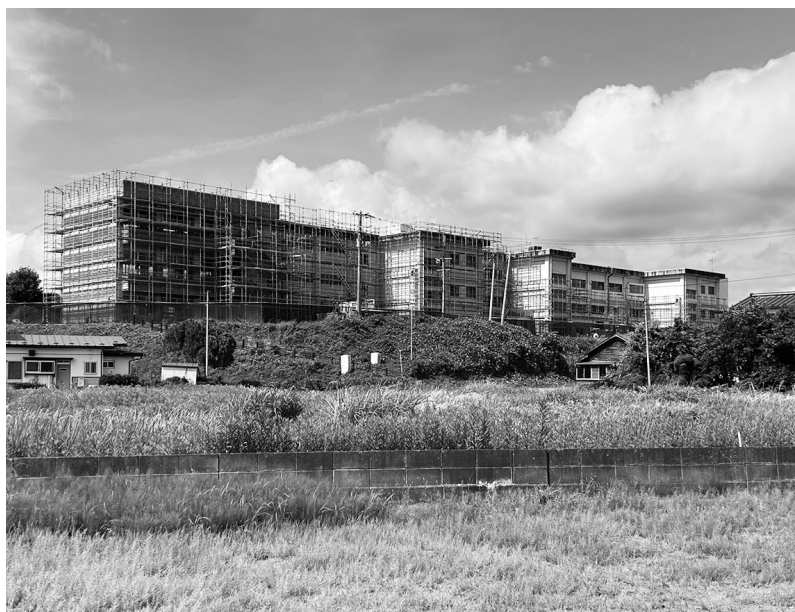
解体が始まった旧不動堂中学校
