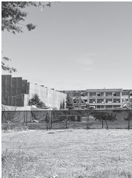
解体工事が進む旧不動堂中学校
