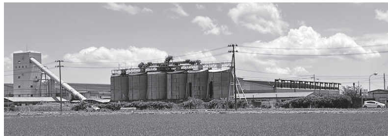
企業誘致が見込まれる 日本高圧跡地
