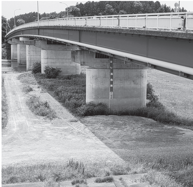
感恩橋に布設する添架管
