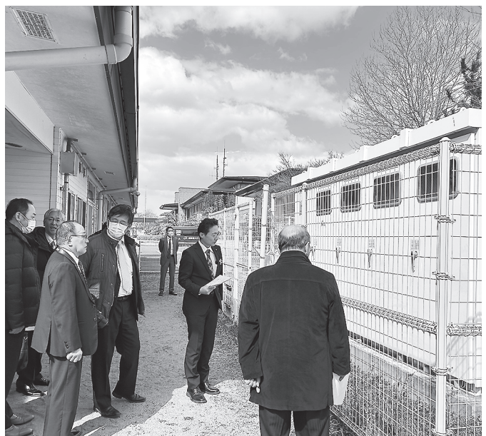
なんごう保育園 高圧機器施設
