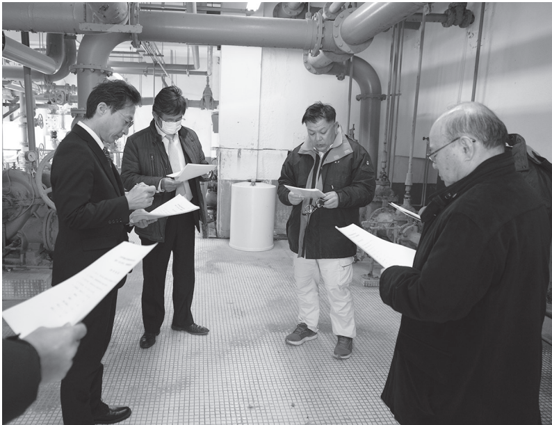
梅ノ木取水場 取水ポンプ施設
