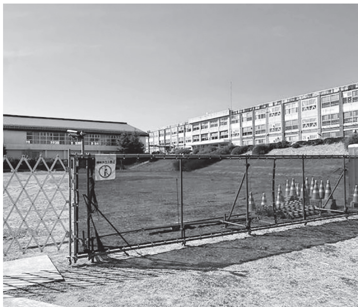
解体する旧不動堂中学校
