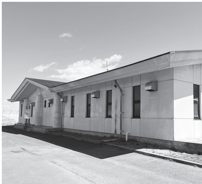
高効率な機械設備に更新
