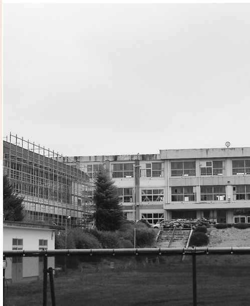
12月に解体を終える旧不動堂中学校
