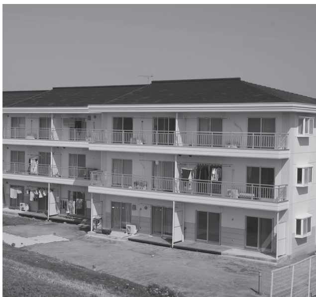
外壁改修工事が行われた町営志賀町住宅
