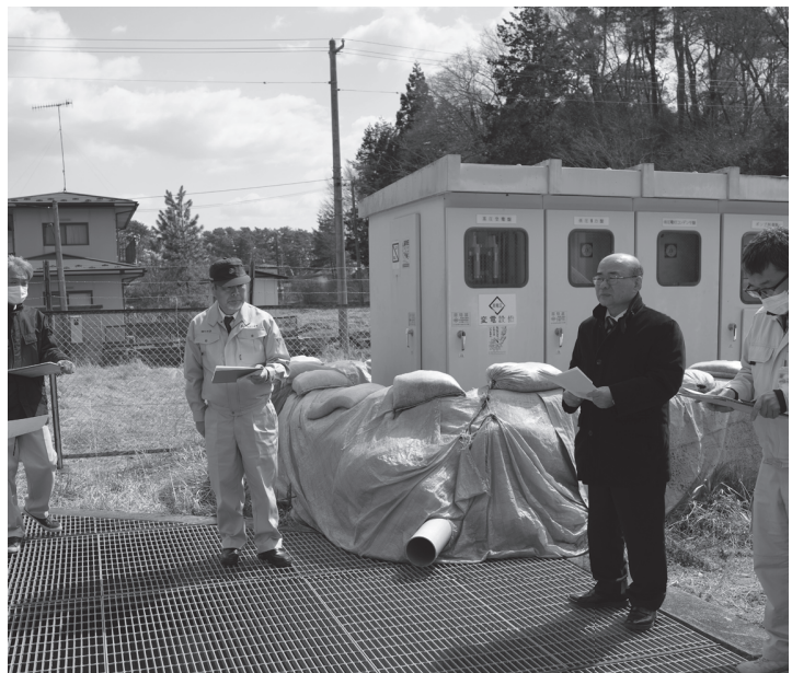
蜂谷森のポンプ配電盤をかさ上げ
