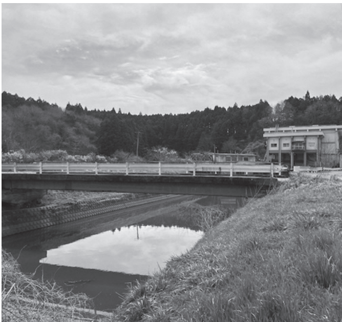
改修工事予定の鞍坪橋
