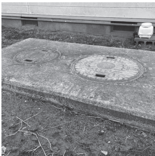
下水道から合併浄化槽に切替え
