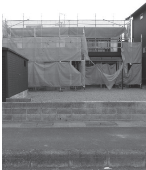
空き家の改修
