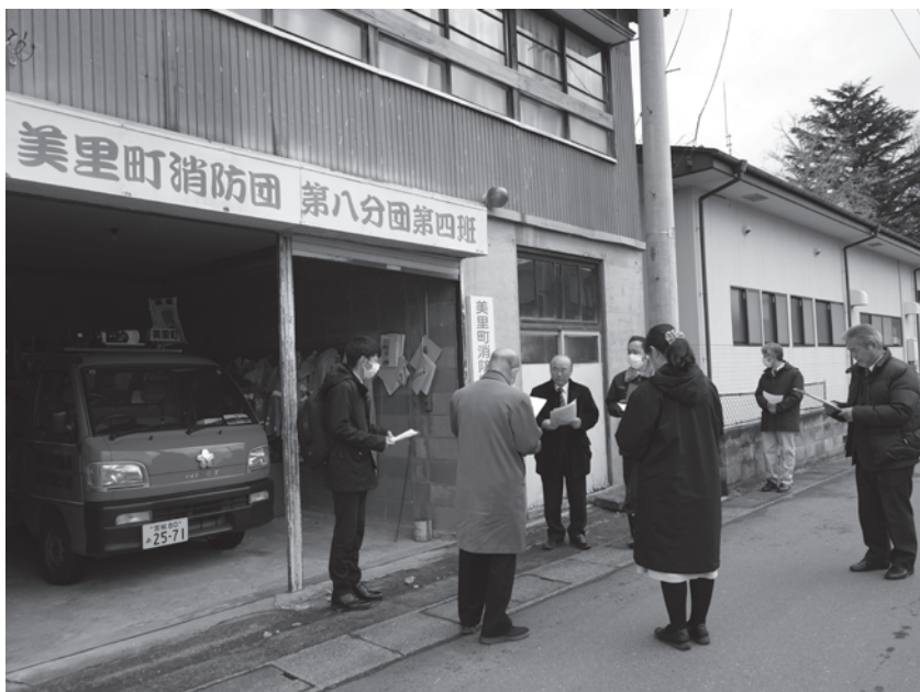
建替えされる消防車庫
