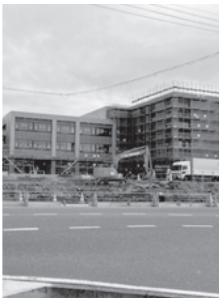
予定通り進む新中学校建設
