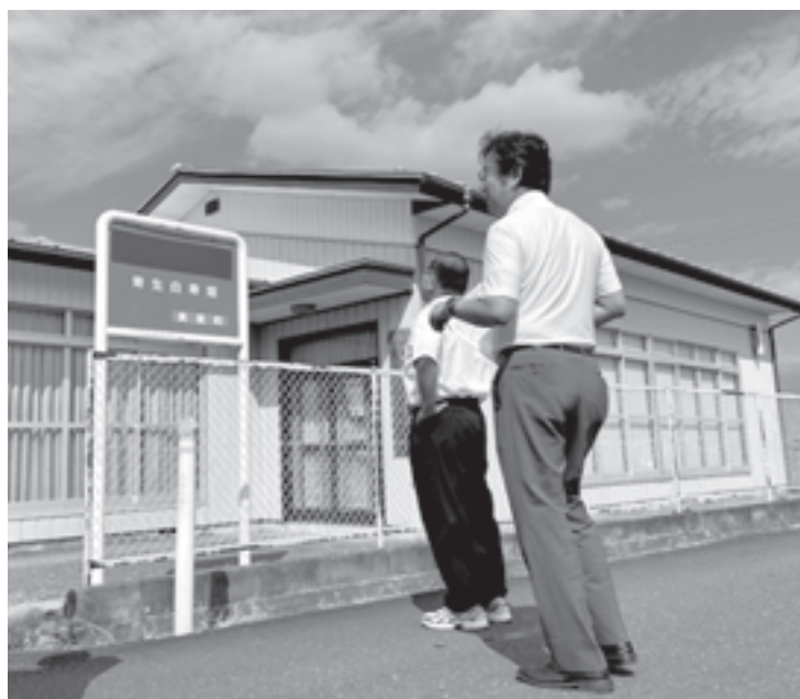
現地調査(屋根修繕後の青生白寿館)
