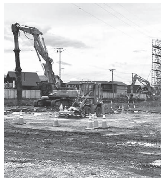
造成が進む新中学校予定地
