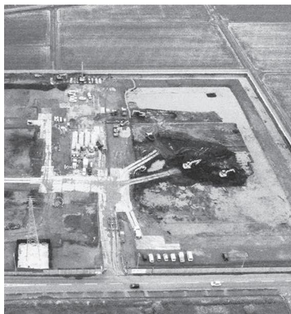
建設中の新中学校
