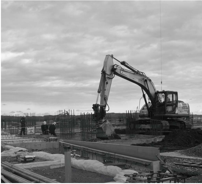
建設が進む美里中学校
