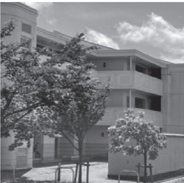
志賀町住宅長寿命化計画により改修
