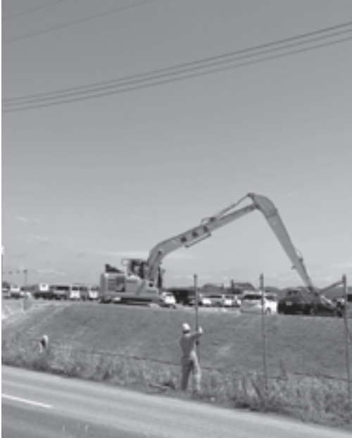
造成工事が完了し建物工事へ
