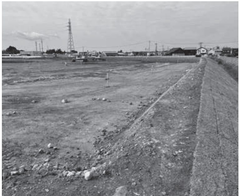
7月から建物工事始まる
