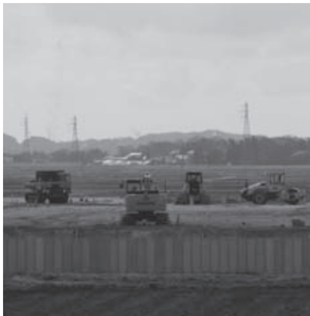
工事が進む新中学校
