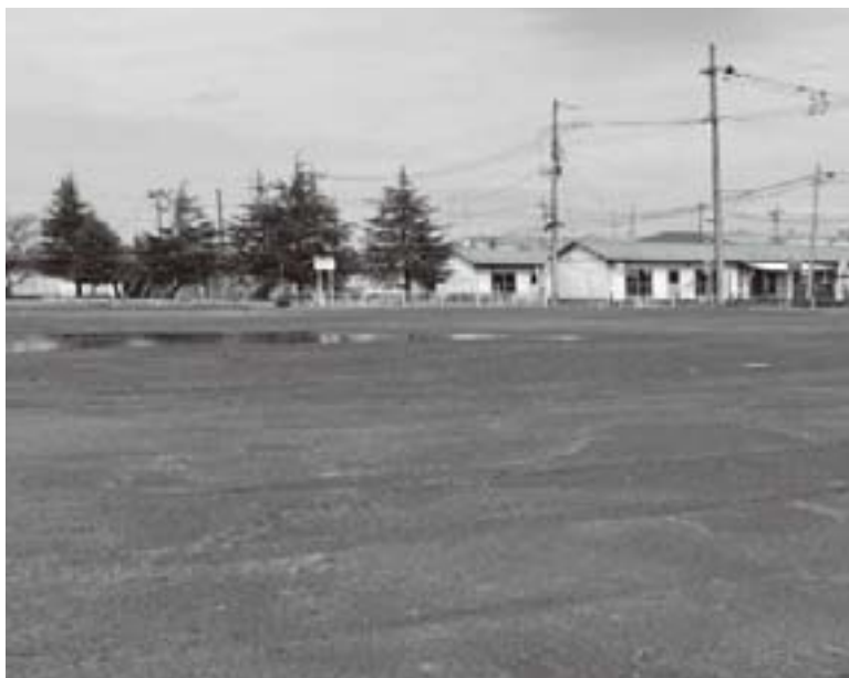
解体整備工事完了
