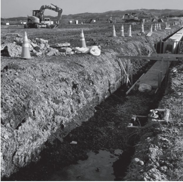
新中学校の側溝工事
