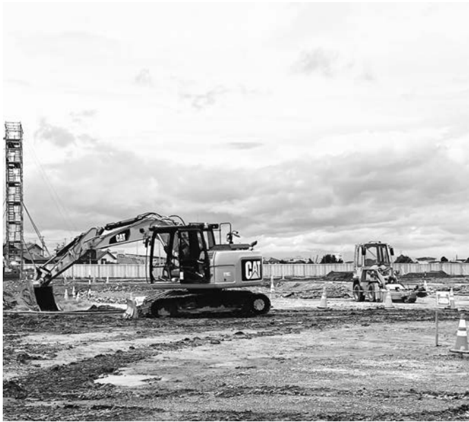
変更契約を締結した新中学校地盤改良工事
