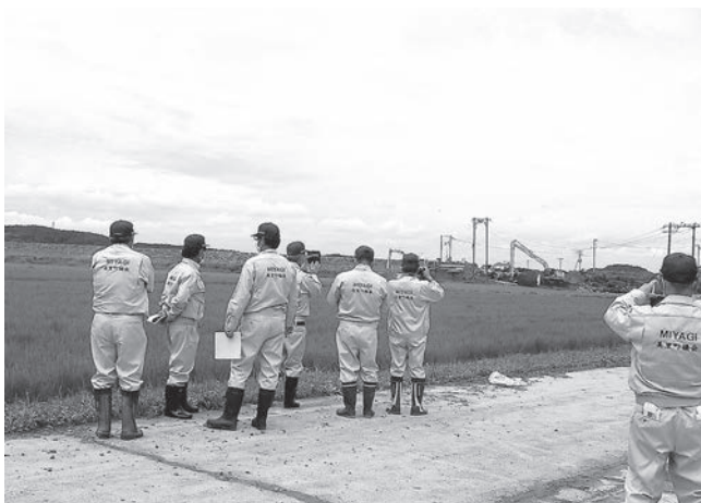
決壊した出来川堤防（鳥谷坂地区）
