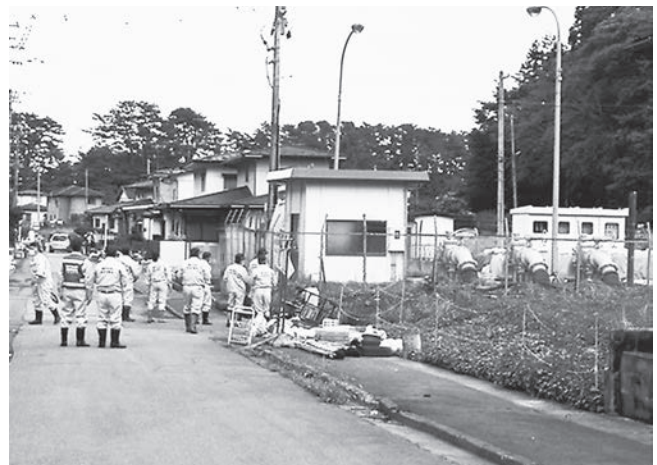
浸水により停止した雨水ポンプ施設（姥ヶ沢地域）
