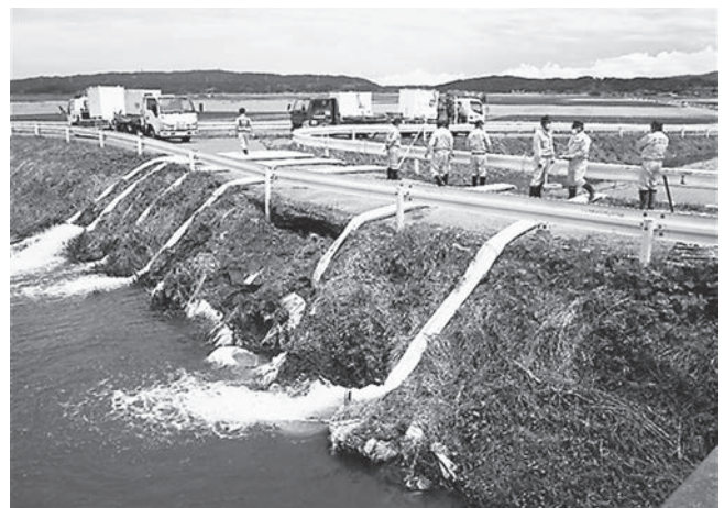
水没した名鰯地区の排水作業
