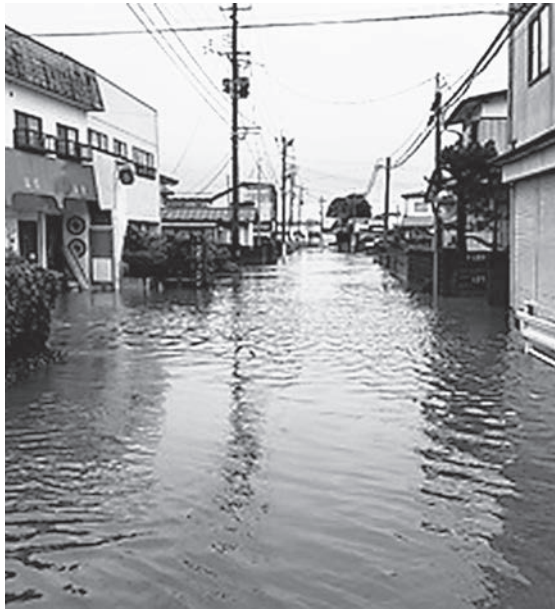
大雨時通行止めになる県道（中坪地区）
