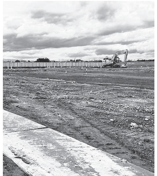
造成が進む新中学校予定地
