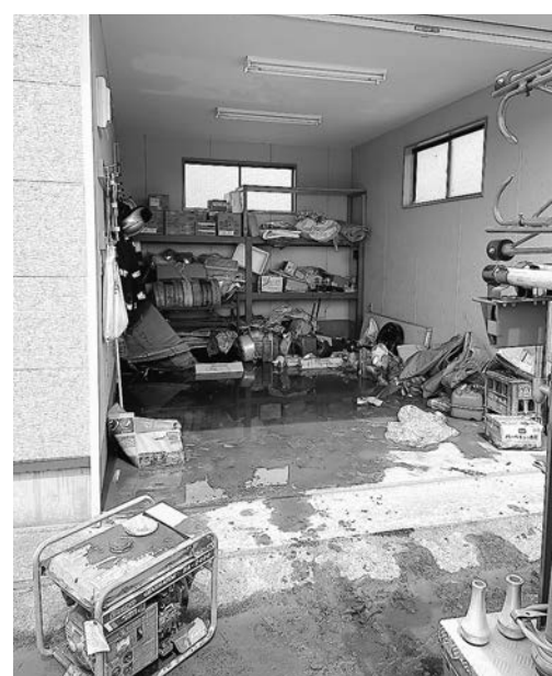
水没した鳥谷坂のポンプ小屋
