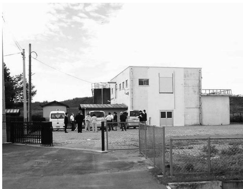
現地調査（整地された旧梅ノ木浄水場跡）
