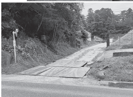
管理用道路新設
