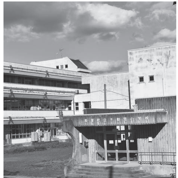
雨漏りが見つかった不動堂小学校
