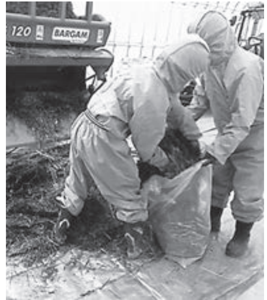
試験焼却での前処理
