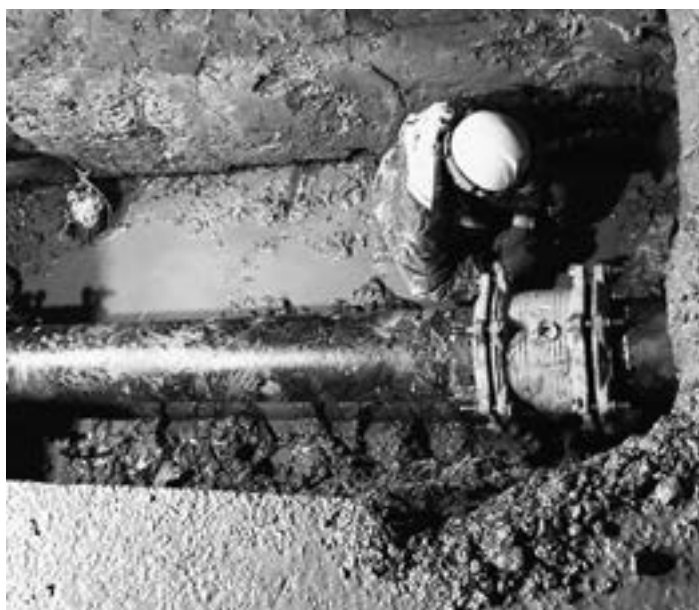
漏水した水道管の修繕工事の様子
