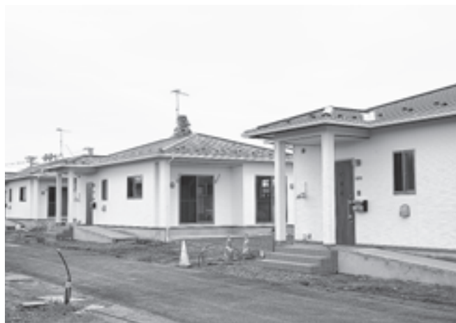
完成間近な町営住宅
