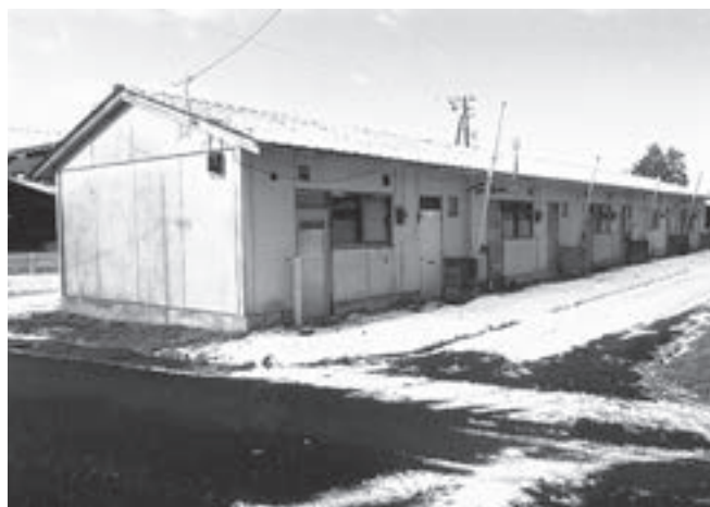
老朽化した町営住宅
