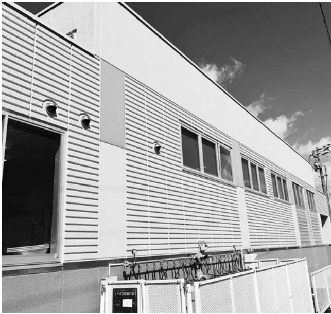
南郷学校給食センターの排煙窓
