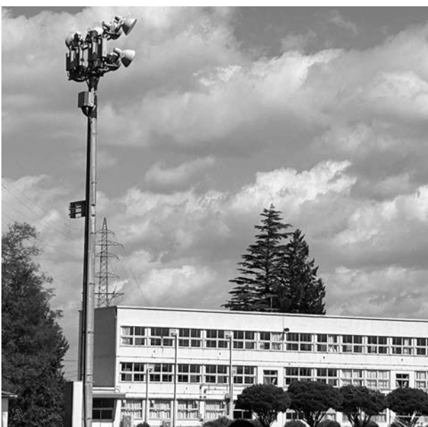
閉校後の管理(旧小牛田中学校照明設備)
