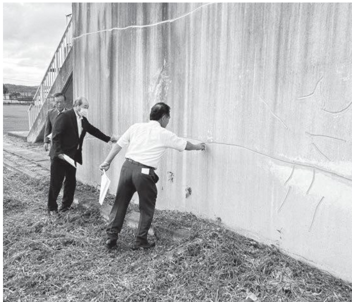
補修された浄水場沈殿池の外壁
