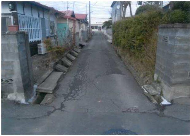
整備前 山の神変電所線 外12路線
