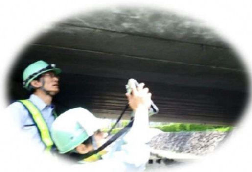
【タブレットによる点検】
