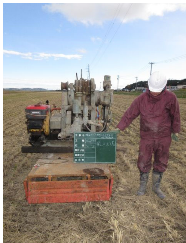
資機材運搬状況
