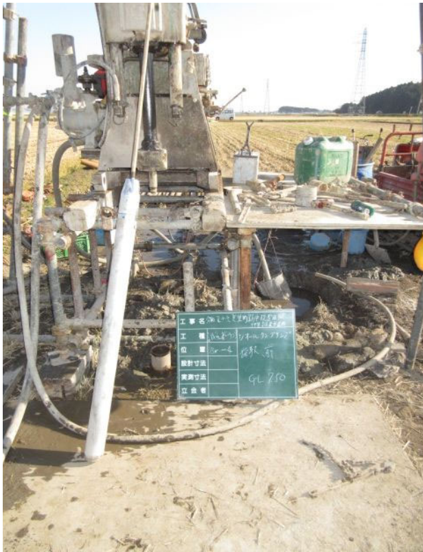
シンウォールサンプリング状況 (深度7.5m)
