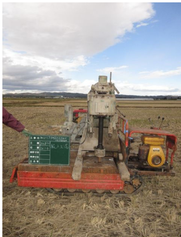
資機材運搬状況
