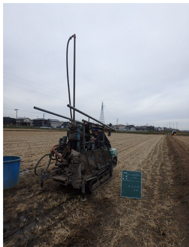
資機材運搬状況
