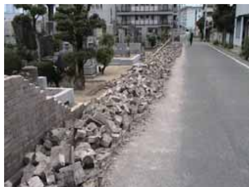
写真-8.1 福岡県西方沖地震によるブロック塀の倒壊
