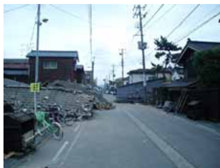
写真-1.1 新潟県中越沖地震による住宅の倒壊の状況
