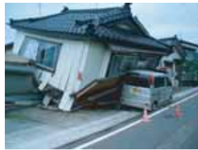
全壊した住宅の状況 (H19 新潟県中越沖地震)
