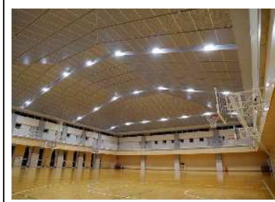
照明器具のLED化
