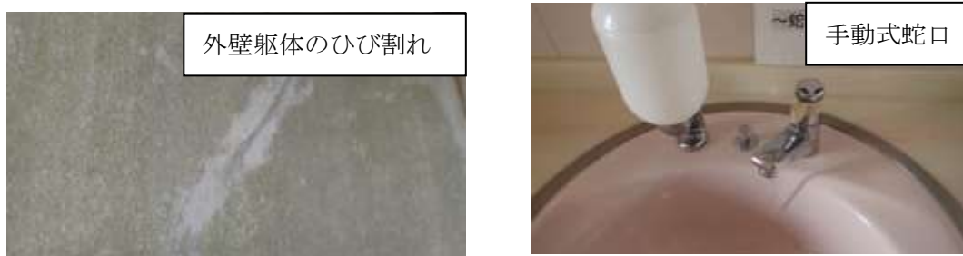
図 4 劣化した部材の例
