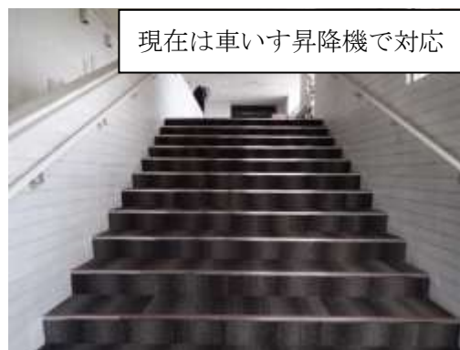
図 5 段差解消に対する改善が必要な例
