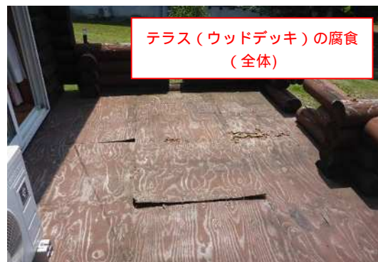
写 6 テラス(ウッドデッキ)：腐食【D判定】
