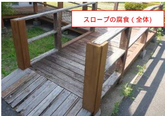
写 5 スロープ：腐食【D判定】
