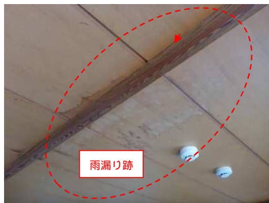
写 3 天井：雨漏り跡【C判定】
