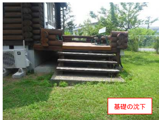
写 4 テラス：基礎の沈下【D判定】
