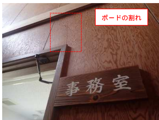
写 8 内壁：ボードのひび割れ【B判定】
