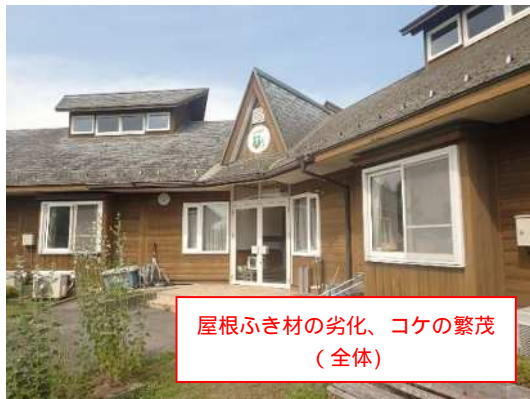
写 1 屋根：劣化、コケ繁茂【D判定】
