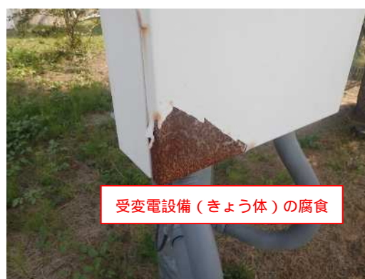
写 10 受変電設備：腐食【B判定】
