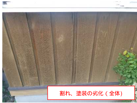
写 2 外壁：割れ、塗装劣化【D判定】
