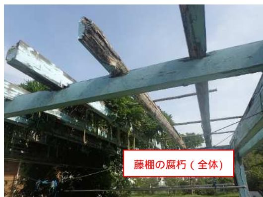
写 9 藤棚：腐朽【D判定】
