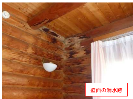
写 7 内壁：漏水跡【D判定】
