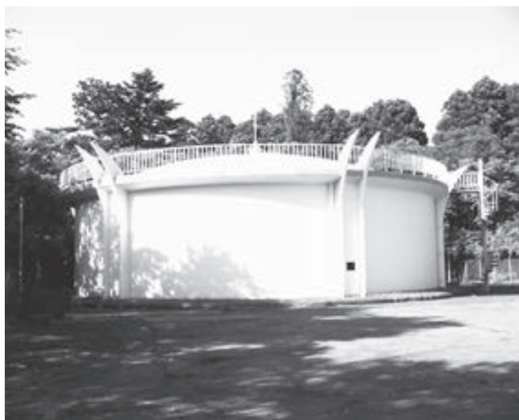
県水だけの柿ノ木平配水場、民営化でどうなる
