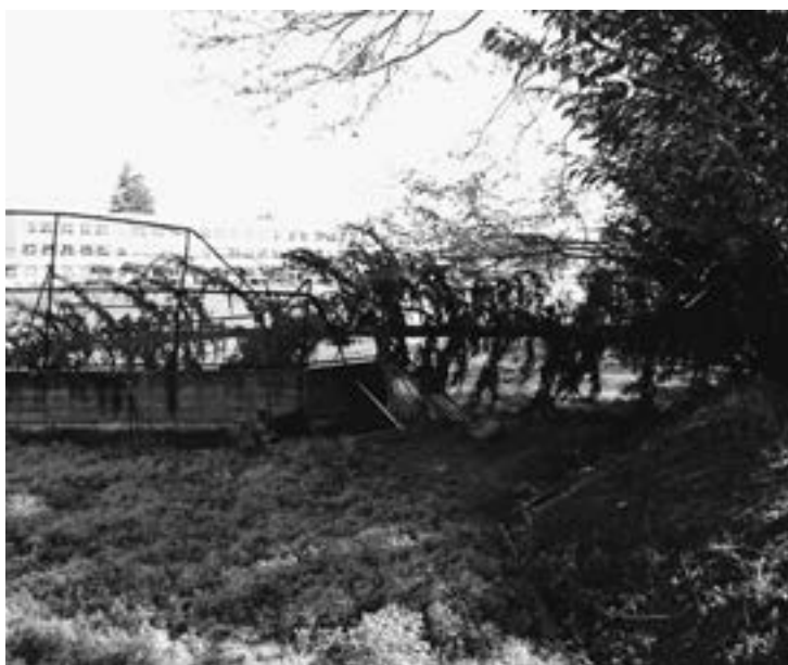
倒木により破損したバックネット
