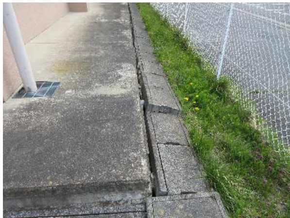
写-2.2.7 外構（不同沈下）【C判定】 （北浦小学校）
