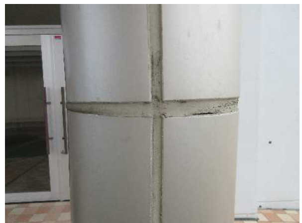
写-2.2.8 外壁躯体（柱のよれ）【C判定】 （中埜小学校）
