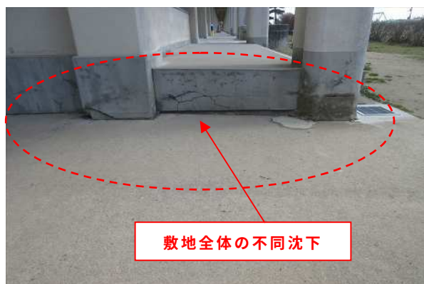
写-2.2.3 外構（不同沈下）【C判定】 （青生小学校）
