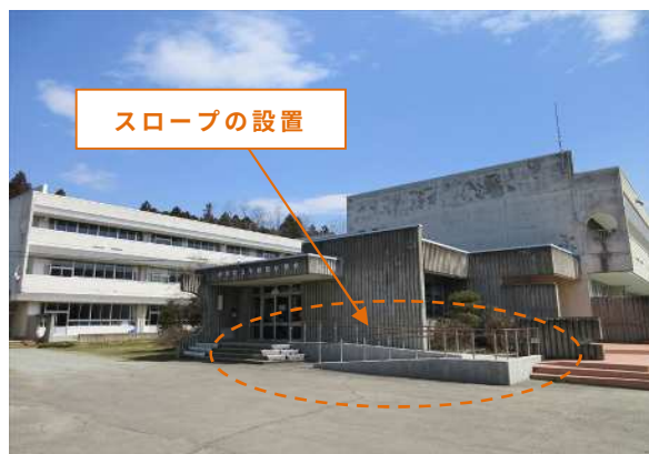
写-1.2.5 段差解消のためのスロープの設置
